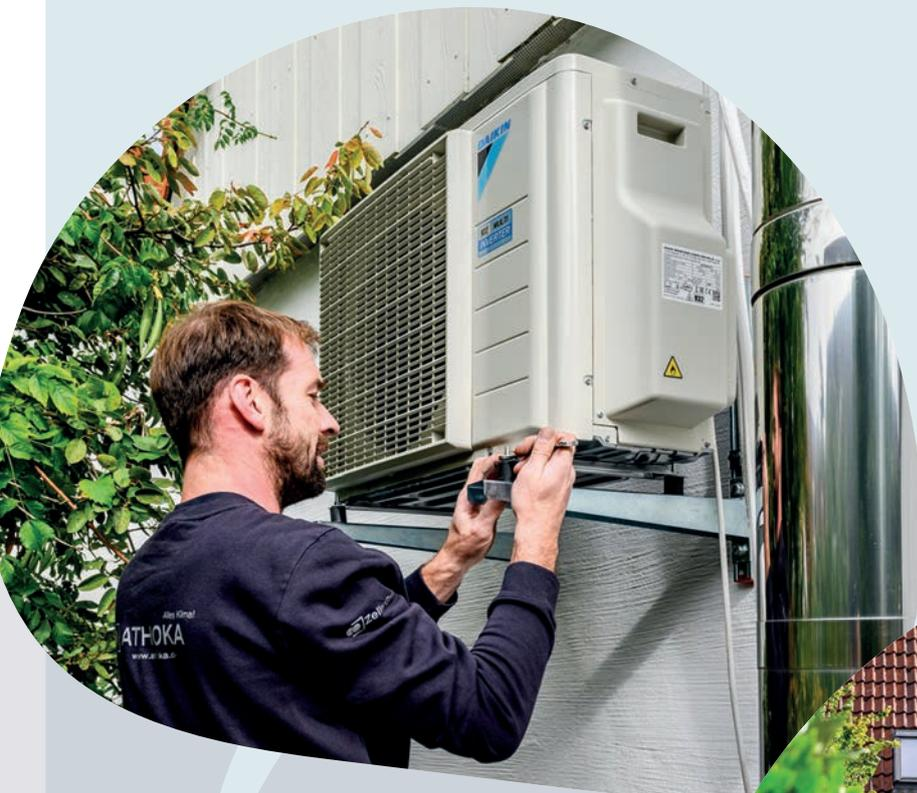
Das Außengerät wurde neben dem vorhandenen Kaminanschluss an der Hauswand angebracht.
